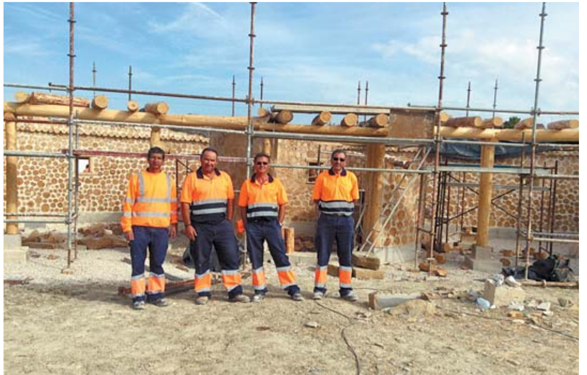
Parte del equipo que construye el aprisco en Mugartea, en Mutilva. Al fondo, el edificio en obras.
