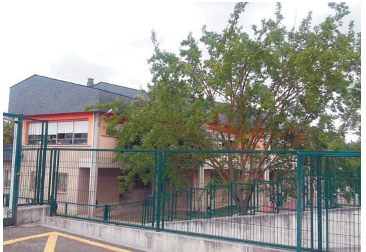
Vista parcial del edificio principal del colegio San Pedro de Mutilva.
