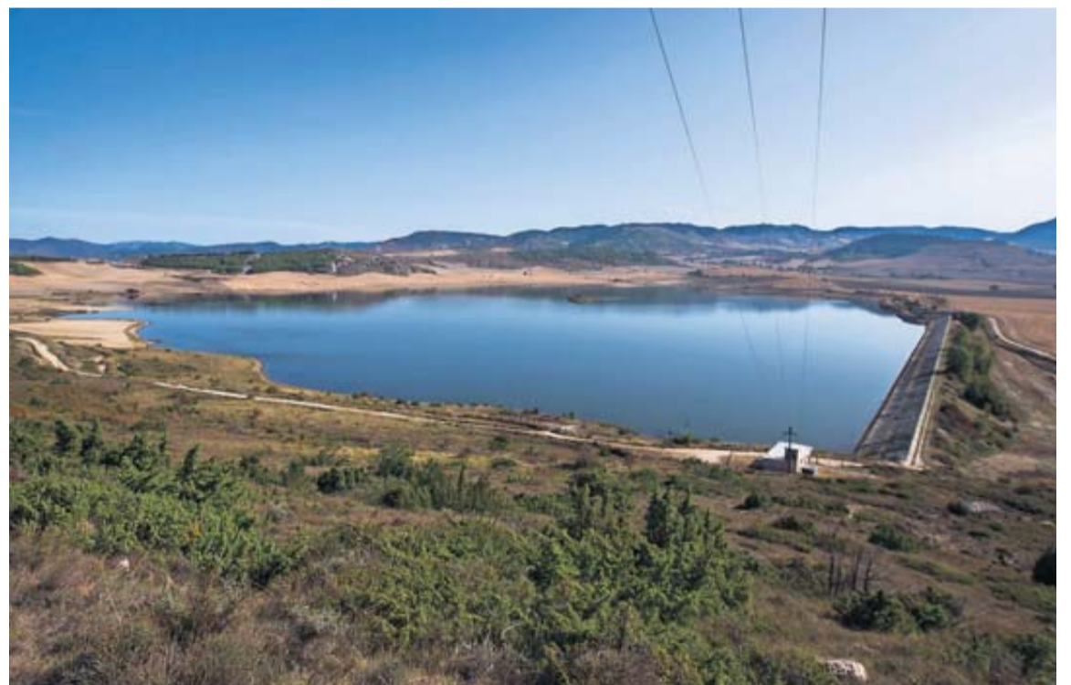
Imagen de la balsa de Zolina. En primer término, la zona de la lámina de agua donde se pretende instalar los paneles solares.
