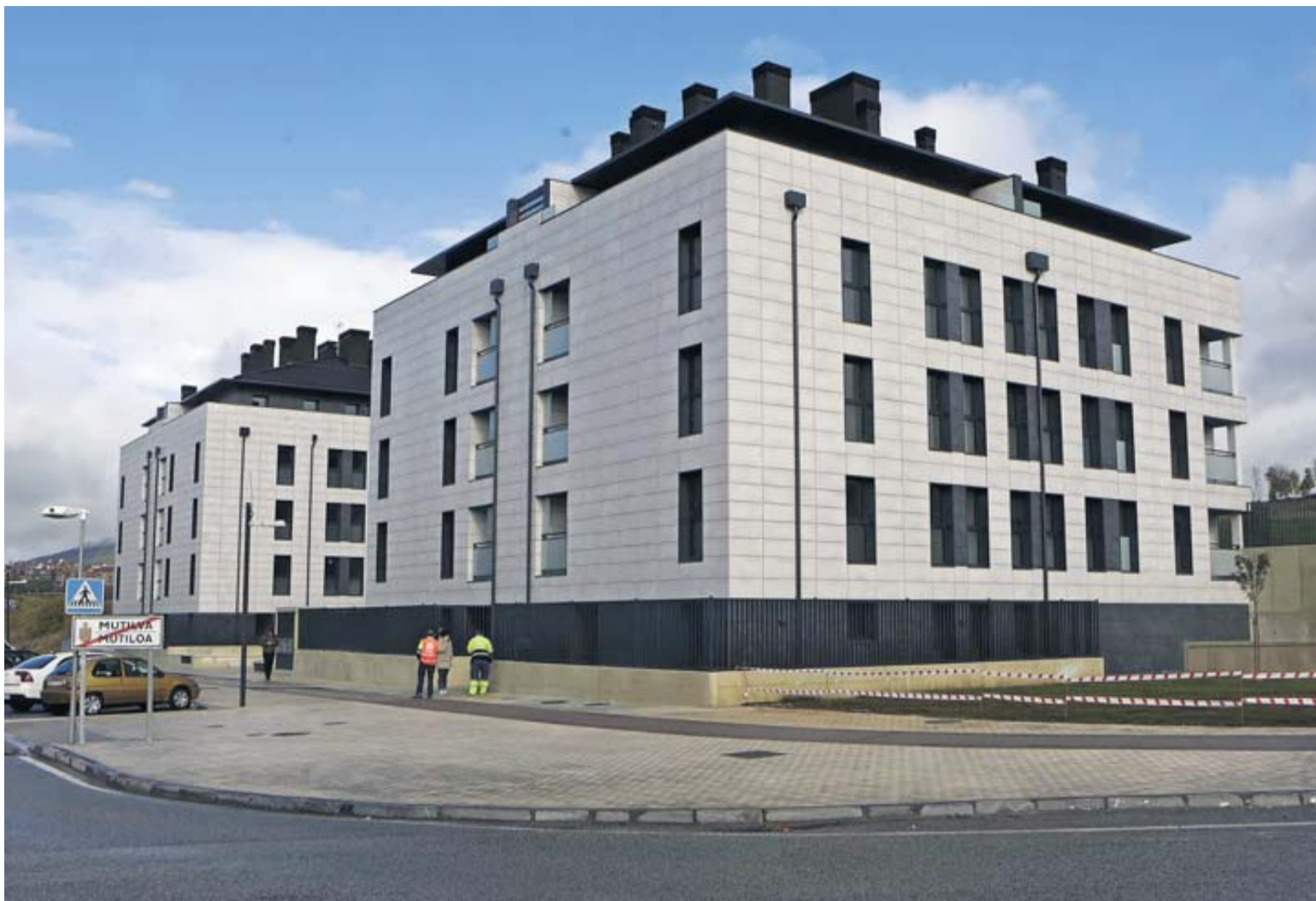
Los dos edificios de alquiler público situados en la avenida de Lezkairu de Mutilva, en la muga entre Aranguren y Pamplona.
