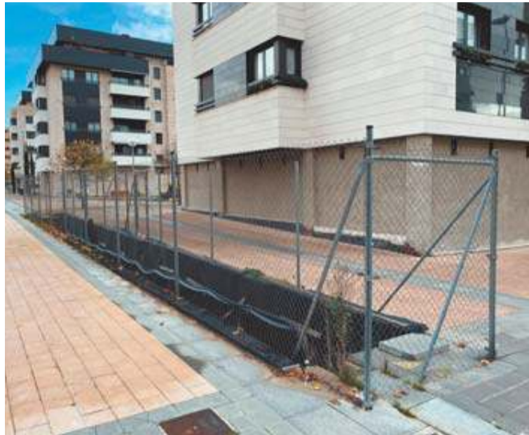
La zanja de la calle Iturriondoa.
