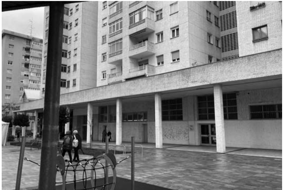
Locales de la avenida Comercial de Barañáin que se van a destinar a centro de día para personas mayores. C.A.M.
