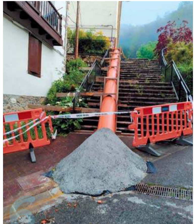
La regata del Calvario fue canalizada por un tubo.
