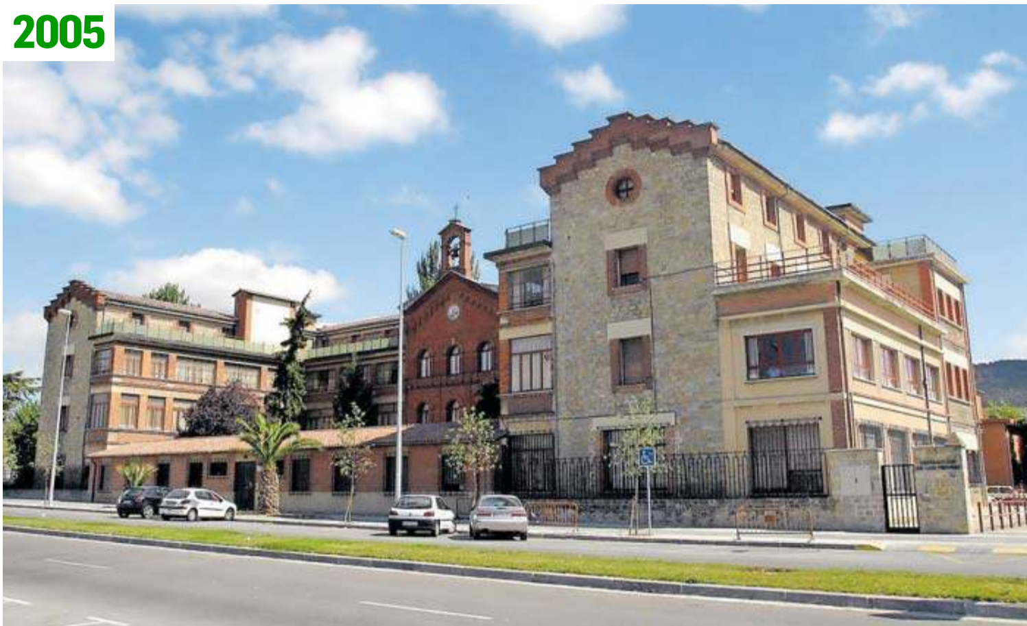
La antigua residencia Hermanitas de los Pobres en la avenida de Guipúzcoa, construida a finales del siglo XIX y demolida en 2007. ARCHIVO/CALLEJA
