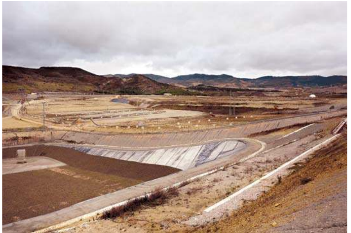
Imagen de archivo de las instalaciones del vertedero de Góngora.
