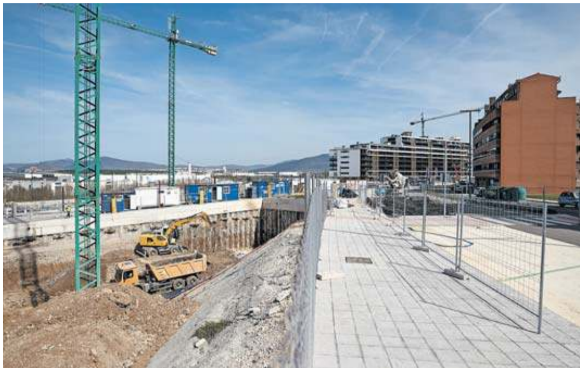
Vista de algunas de las obras de los nuevos pisos en Eulza y de la avenida pendiente de abrir.
