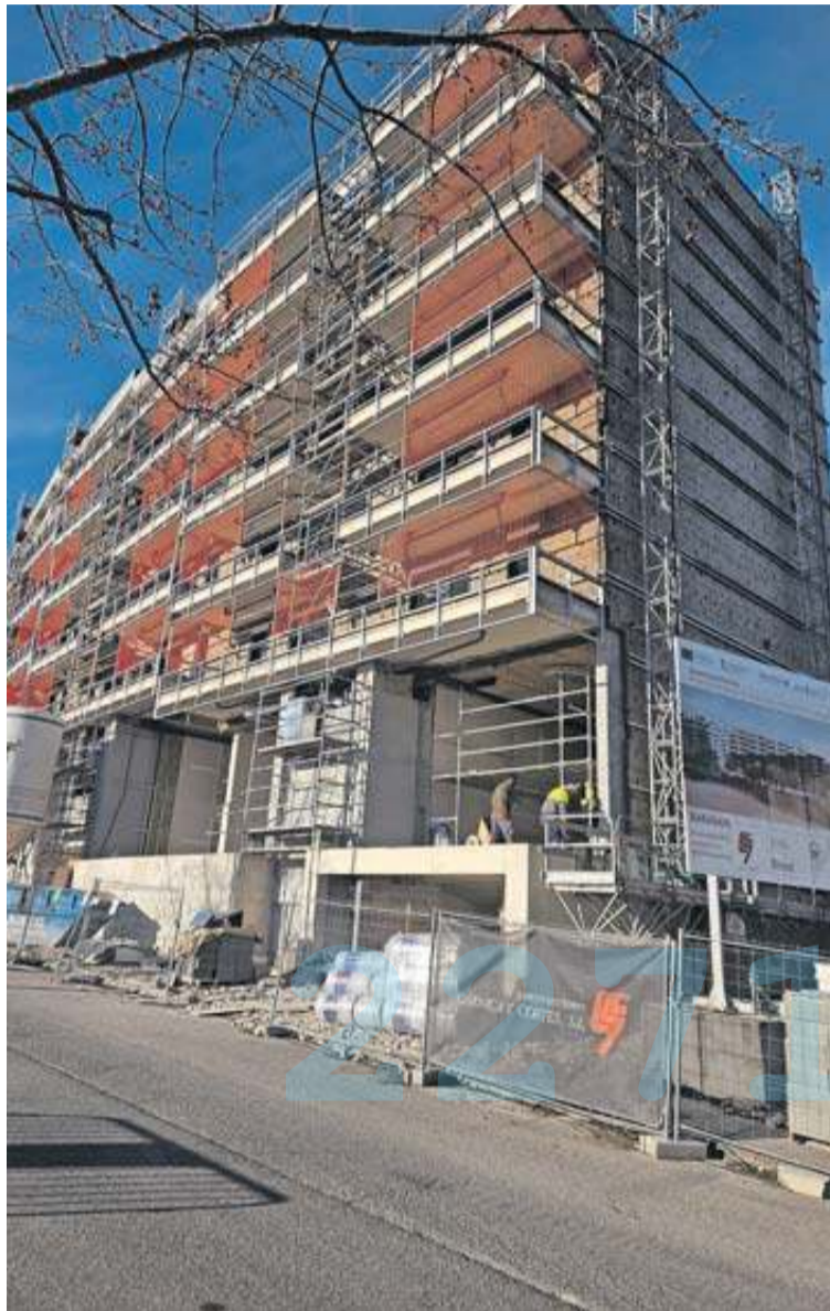
Obras en el bloque de pisos que promueve Nasuvinsa en Barañáin. M.A.M.
